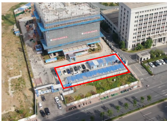
图 1.6 1#施工场地现状图
