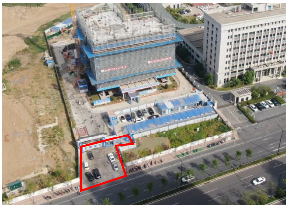
图 1.10 1#施工道路现状
