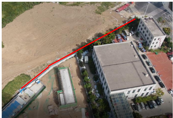
图 1.11 2#施工道路现状图
