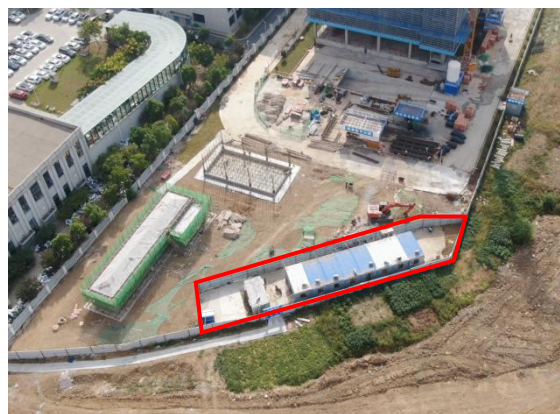
图 1.7 2#施工场地现状图
