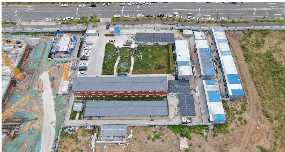
图 1.5 施工场地现状图
