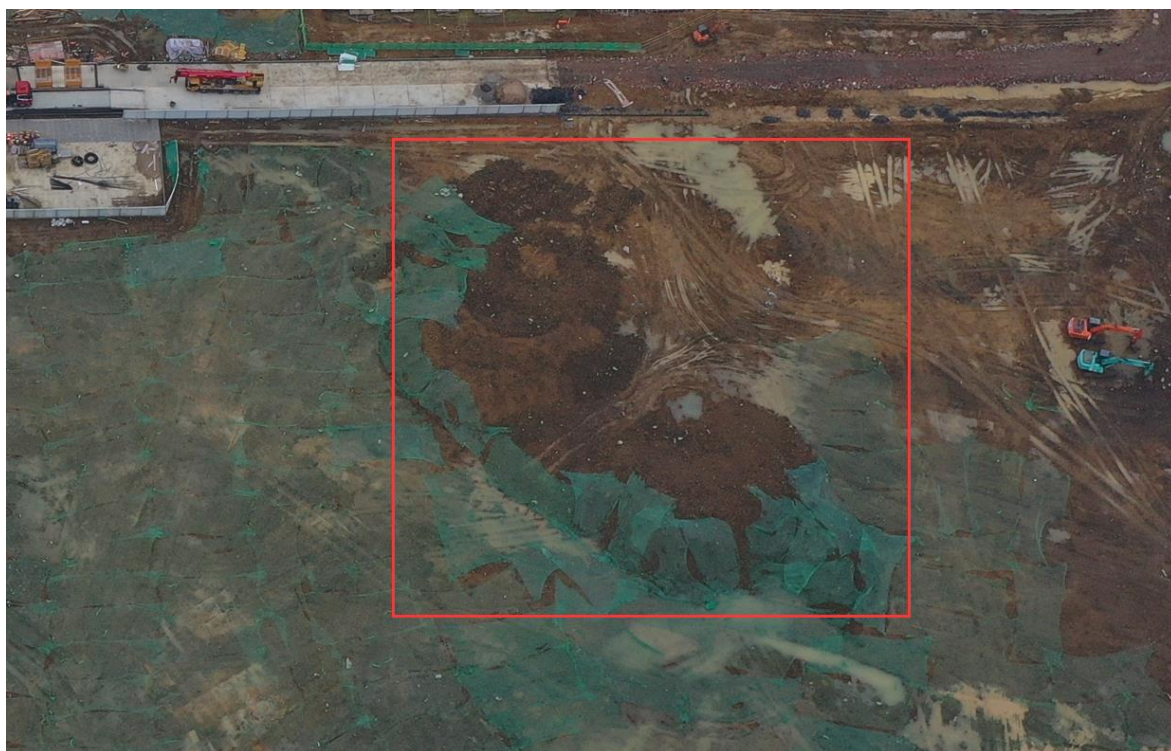
图 1.7 临时堆土场现状
