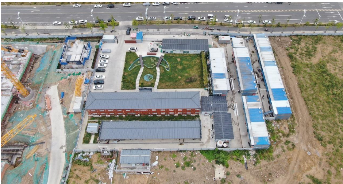
图 1.6 施工场地现状图
