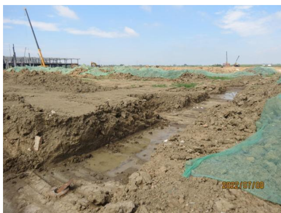
基坑四周裸露堆土苫盖
