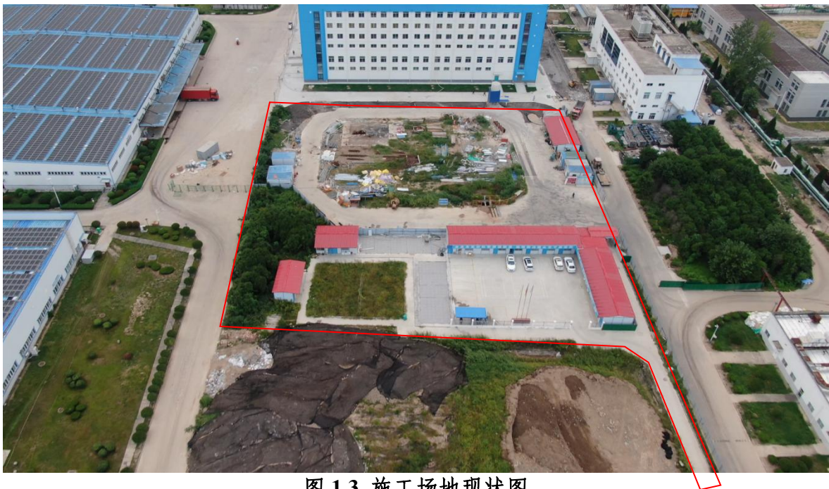
图 1.3 施工场地现状图
