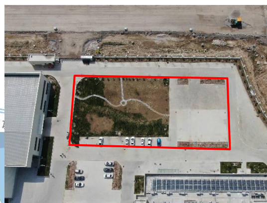
施工场地现状
