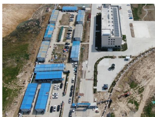
施工生活区现状
