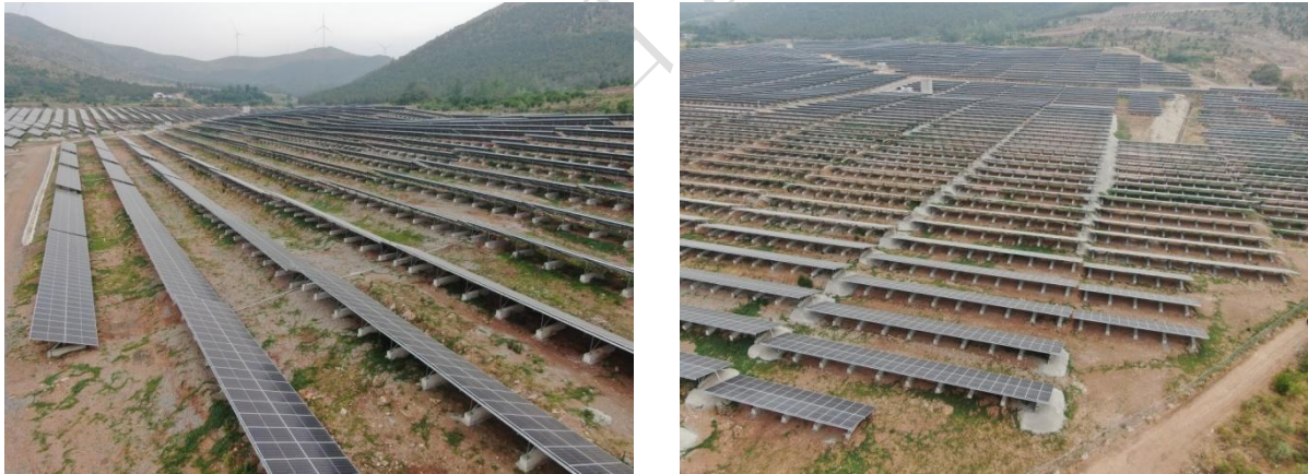
图 1.2 光伏阵列区现状
