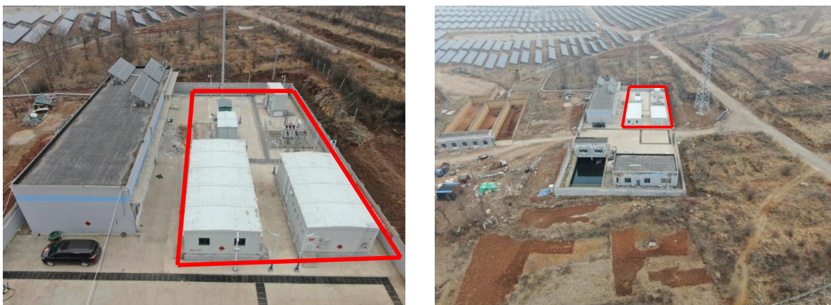
图 1.3 开关站区现状
