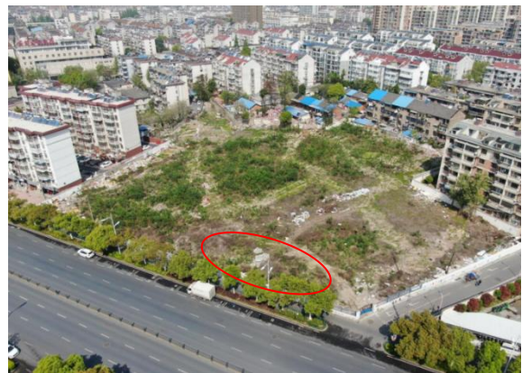
图 1.6 施工场地现状图
