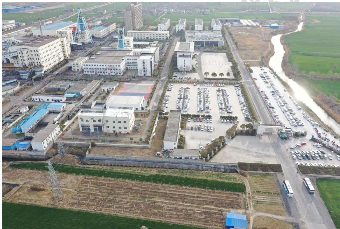
屋顶（含车棚）光伏区域现状
