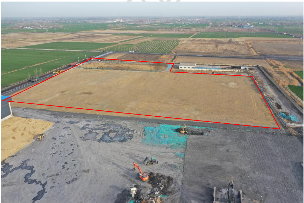
地面光伏区域现状
