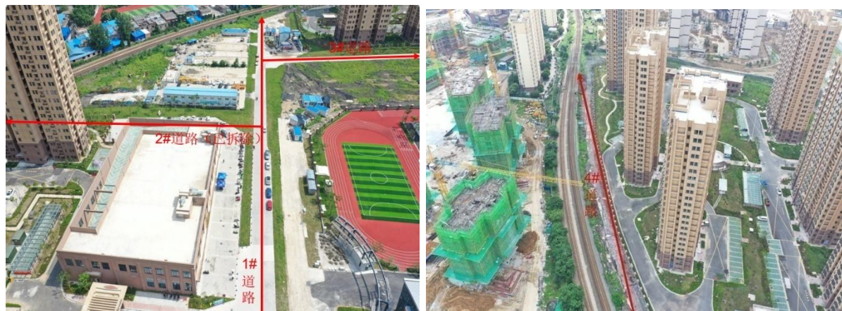
施工道路（施工过程中）
