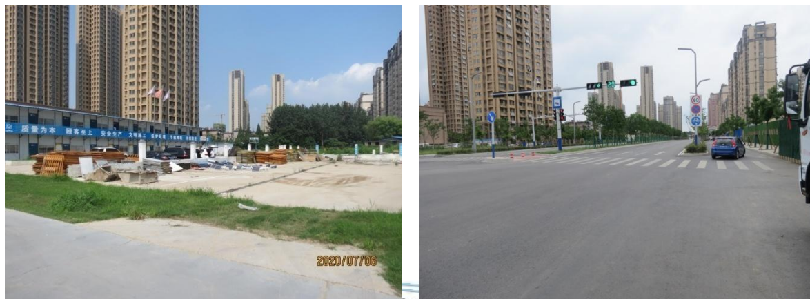
施工过程中施工场地照片 施工场地拆除后建为涂山东路
