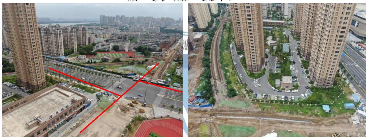
1#、2#、3#施工道路现状
