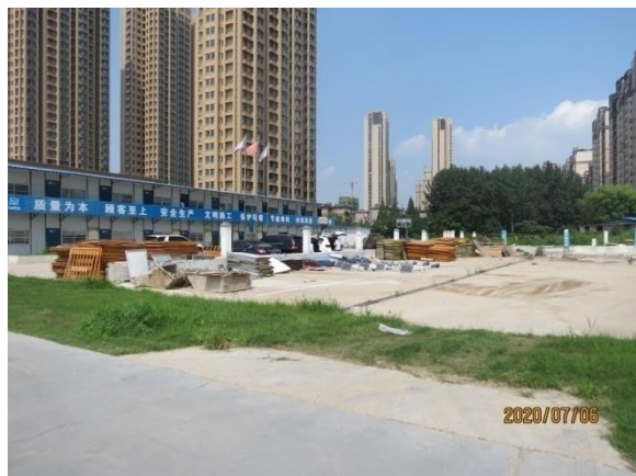
施工过程中施工场地照片
