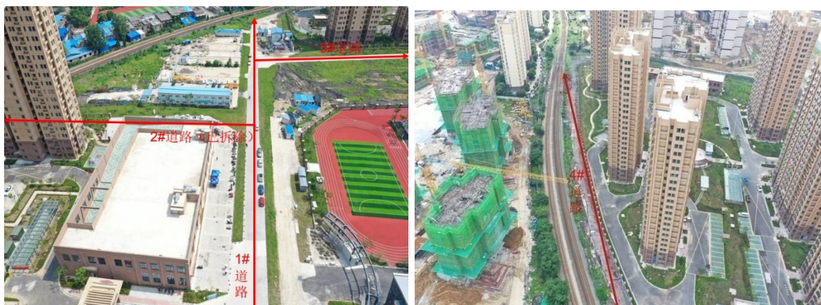
施工道路（施工过程中）
