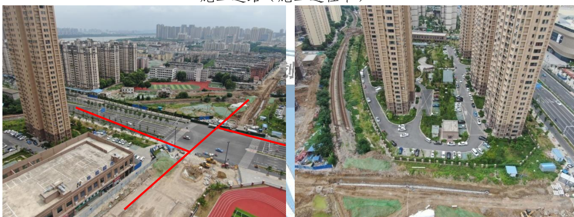
1#、2#、3#施工道路现状
