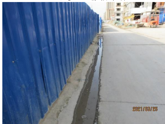
红线退让区沿内部施工便道布设排水沟
