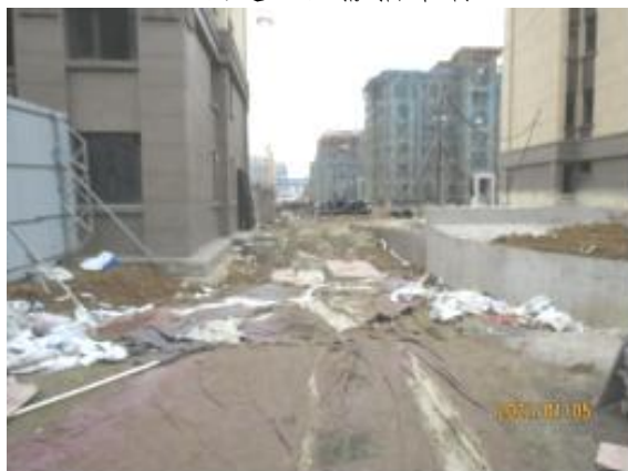
土工布苫盖裸露地表
