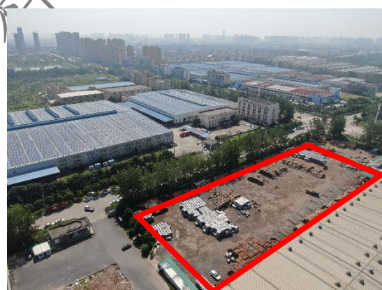
C1#厂房现状
