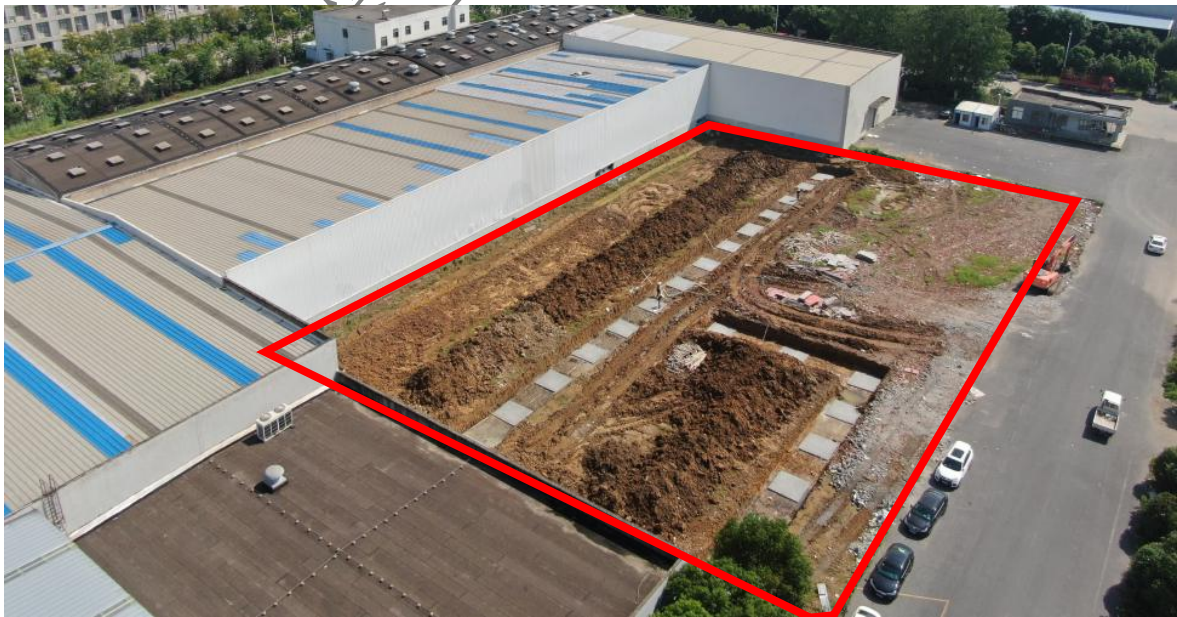
图 2.6 临时堆土场现状
