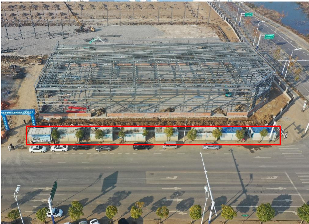
图 1.3 施工场地现状
