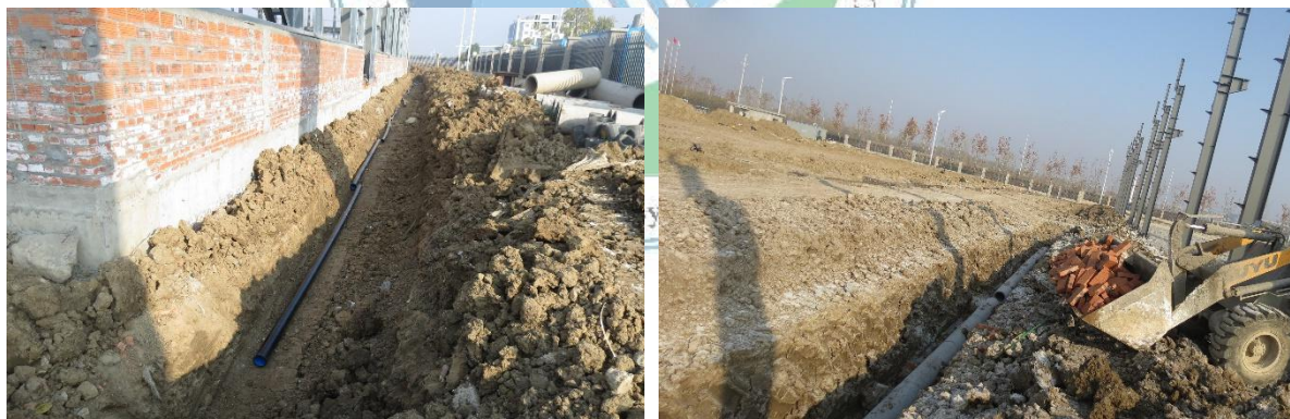
雨水管道现状
