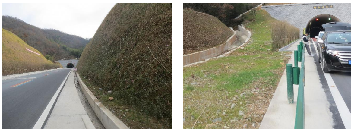
隧道口现状图
