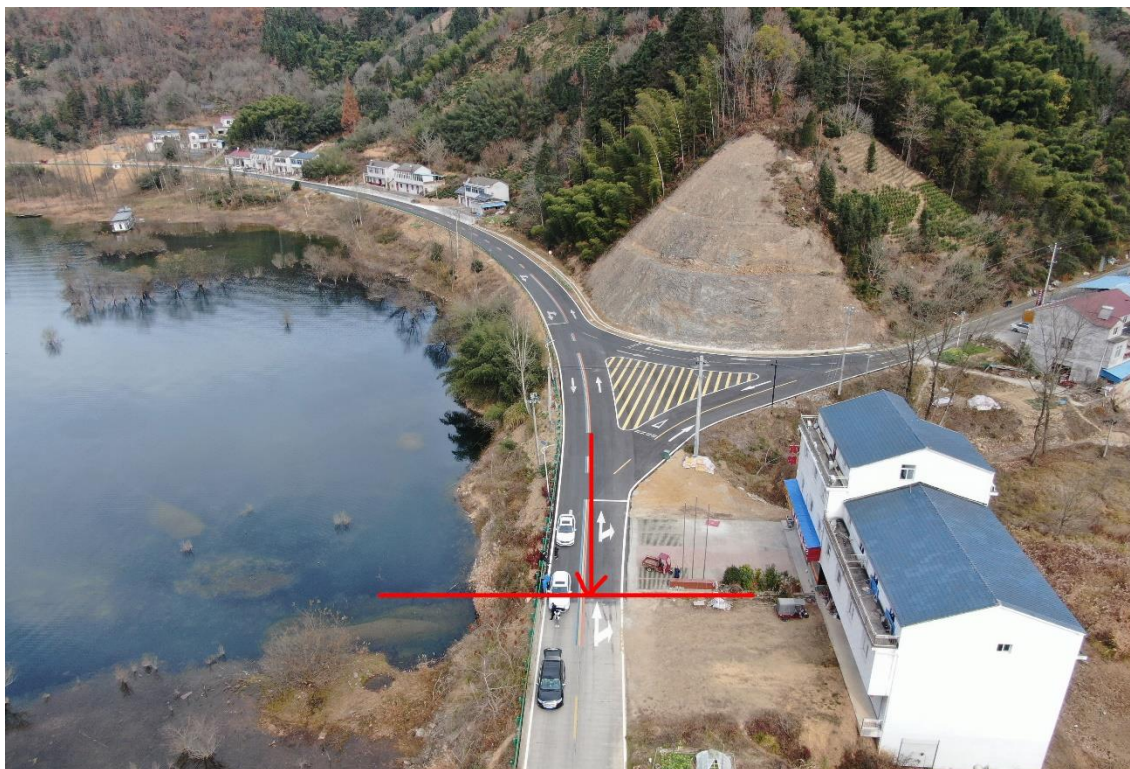
路线终点处现状航拍
