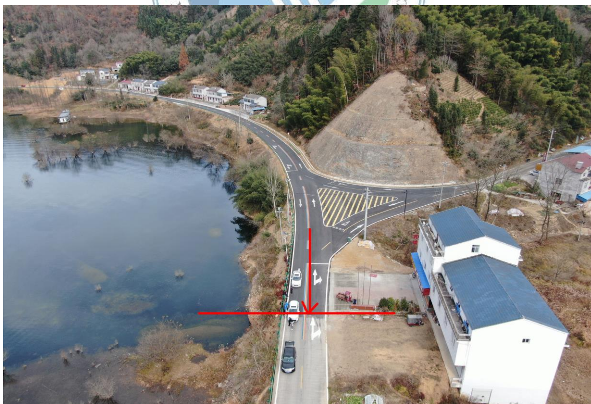
路线建设终点处现状航拍
