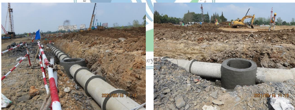
图 3.1 已实施水土保持措施现状
