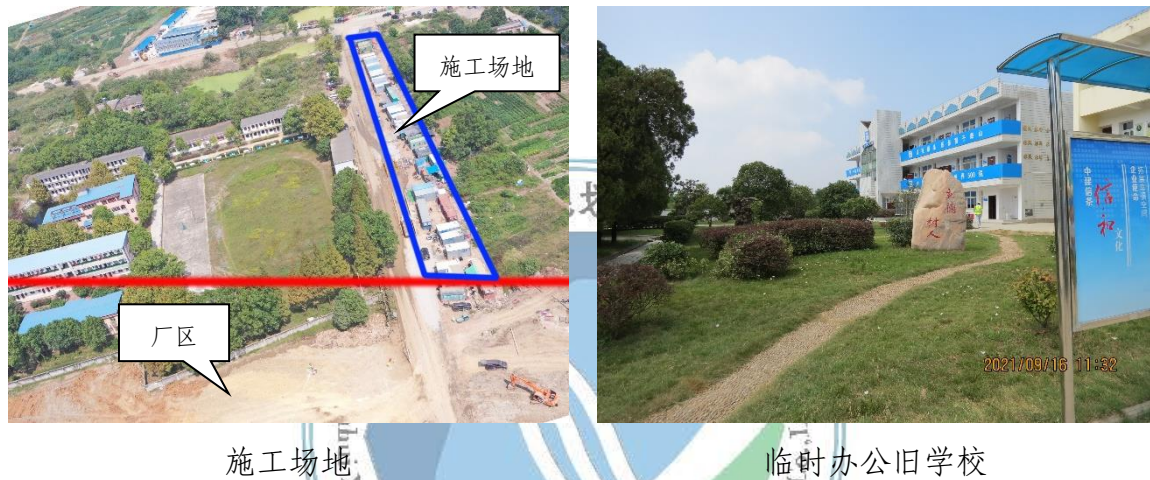
图 2.3 施工生产生活区位置及现状
