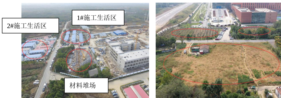
1#、2#施工生活区以及材料堆场（2019.11）
