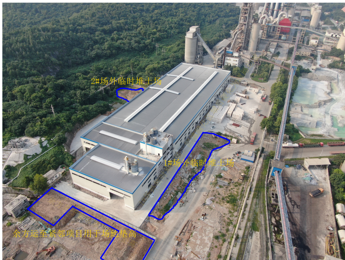
图 1.3 项目临时堆土情况
