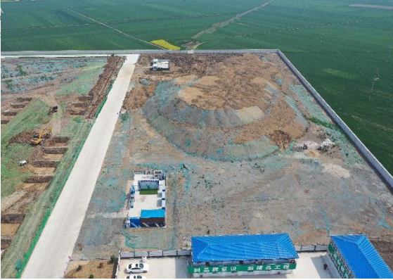
厂区苫盖措施
