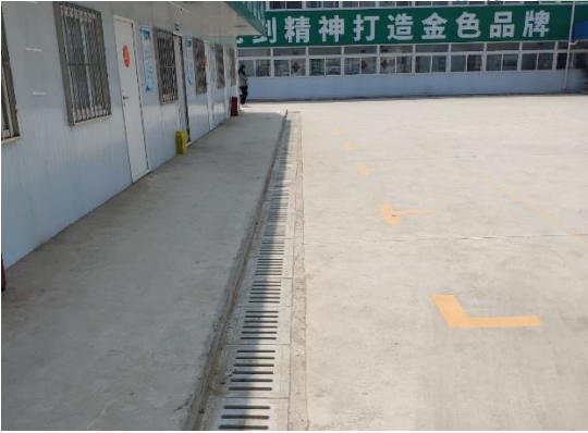
施工生活区临时排水沟
