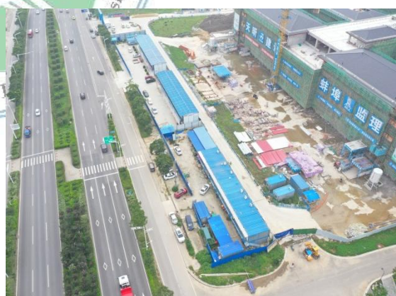
施工场地现状
