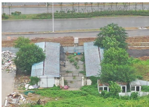
2#施工生产生活区
