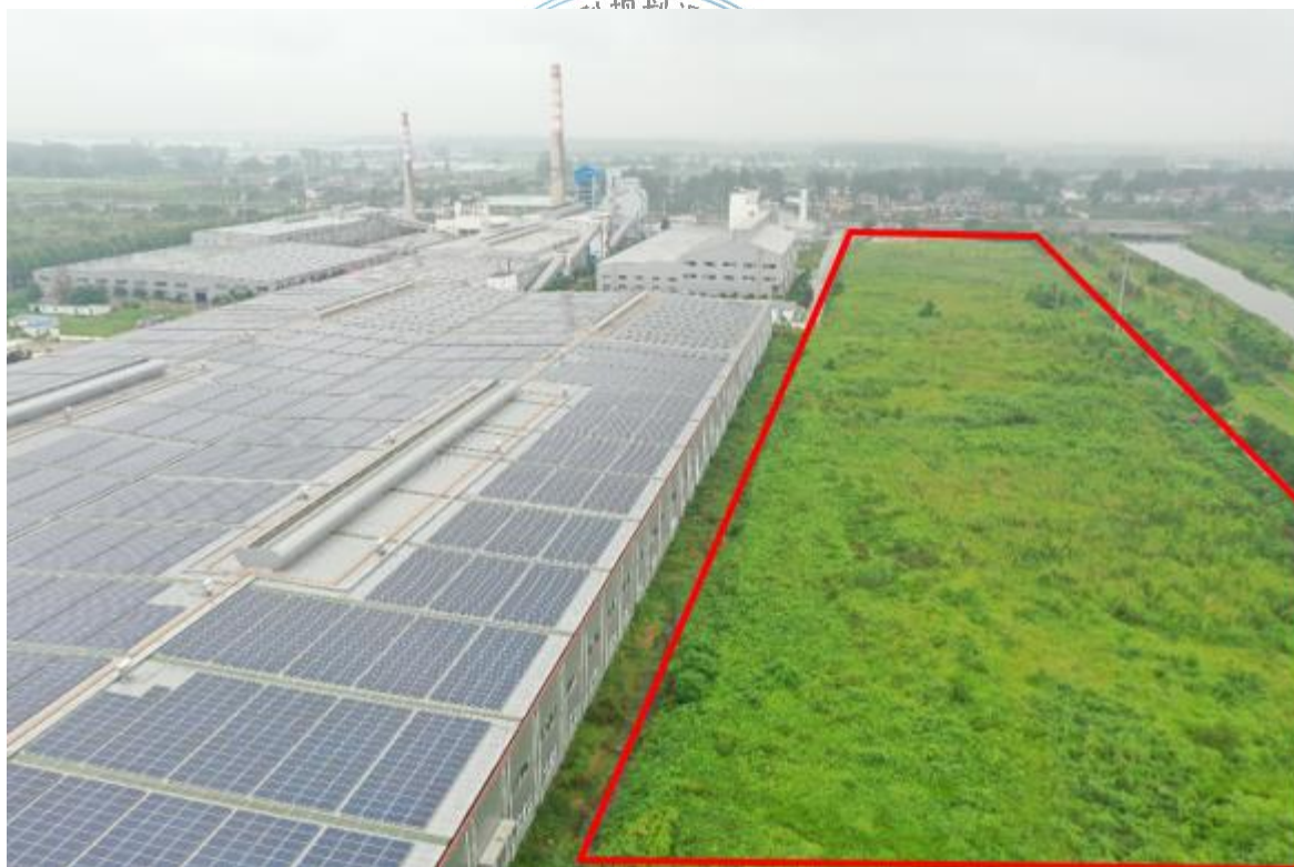
施工结束后植物恢复情况
