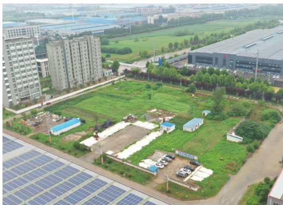
1#施工生产生活区
