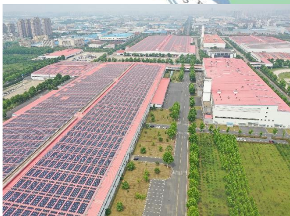
改建区域现状
