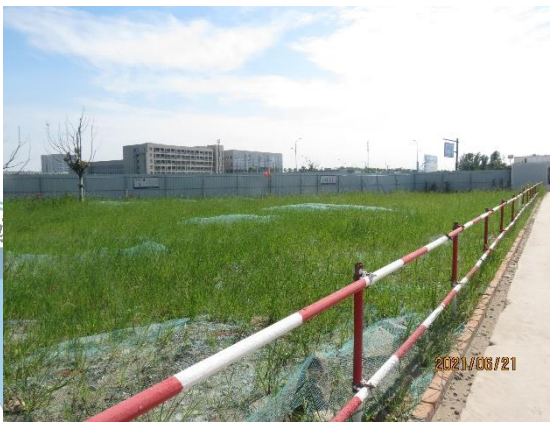
二期预留用地临时苫盖、撒播草籽
