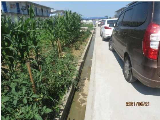
施工生产生活区排水沟
