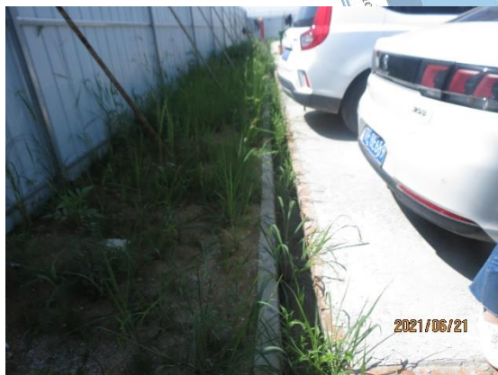
施工生产生活区临时绿化、排水沟
