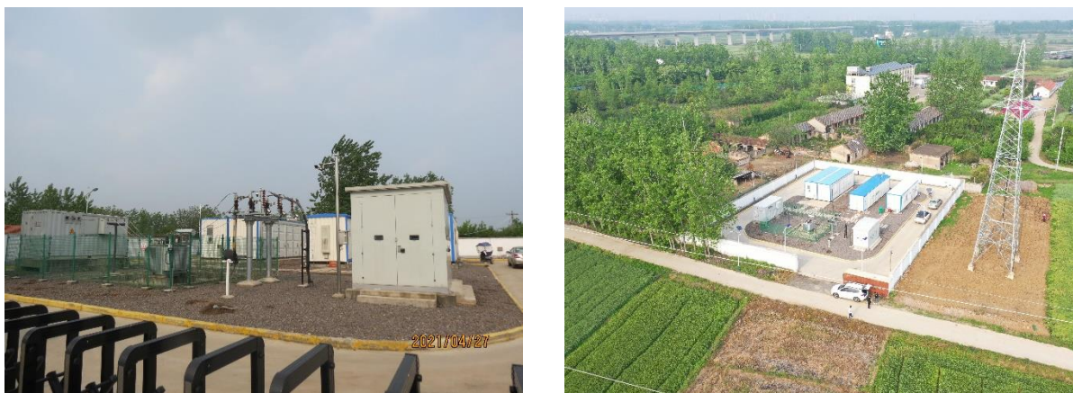
图 1.3 开关站区现状
