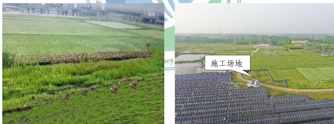
图 1.5 施工场地区现状
