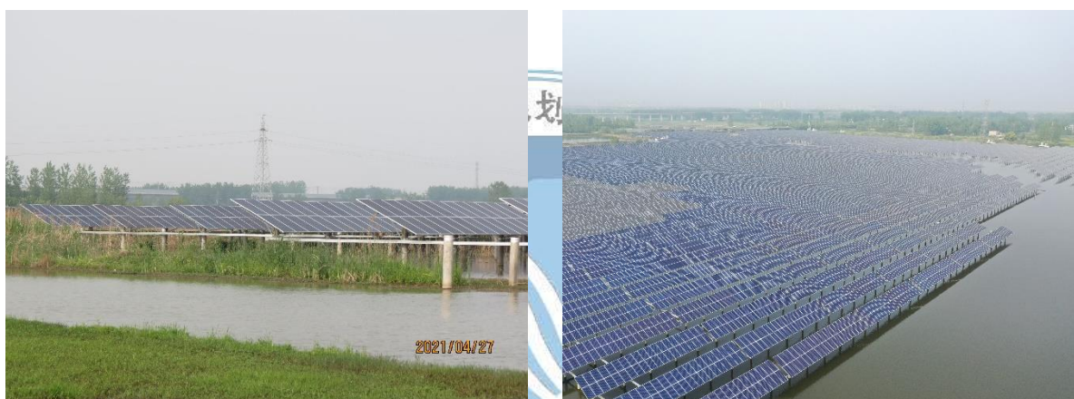
图 1.2 光伏阵列区现状
