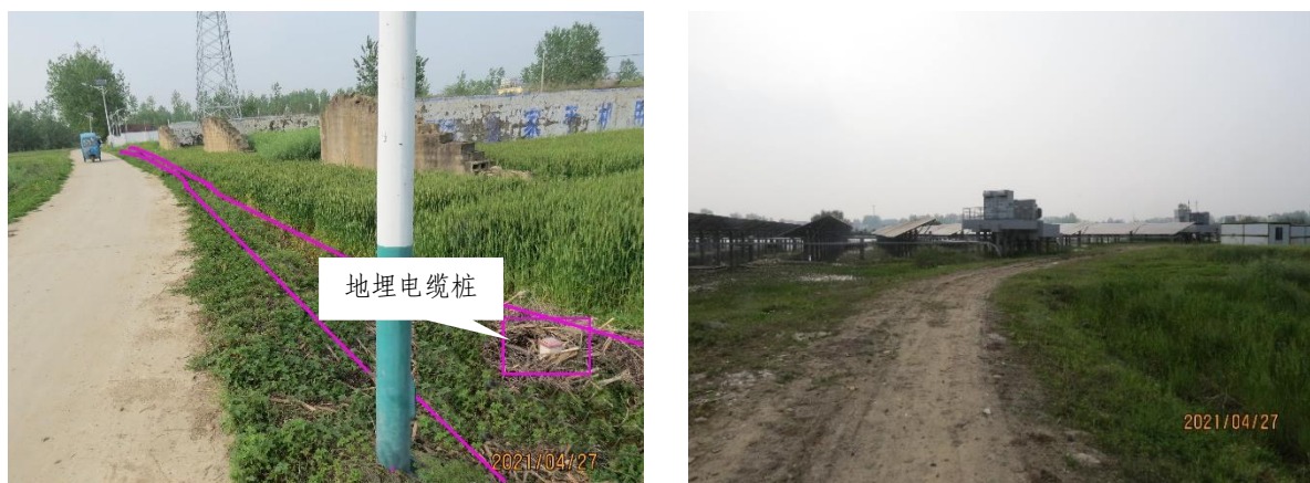
图 1.4 道路及集电线路区现状
