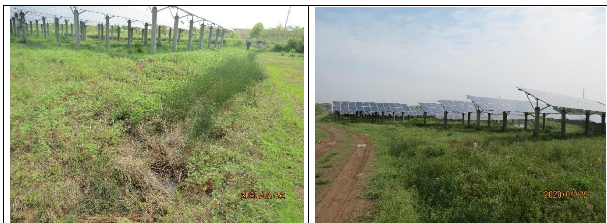
光伏阵列区场地内现状
